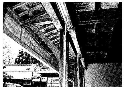
揚戸を上げた状況
